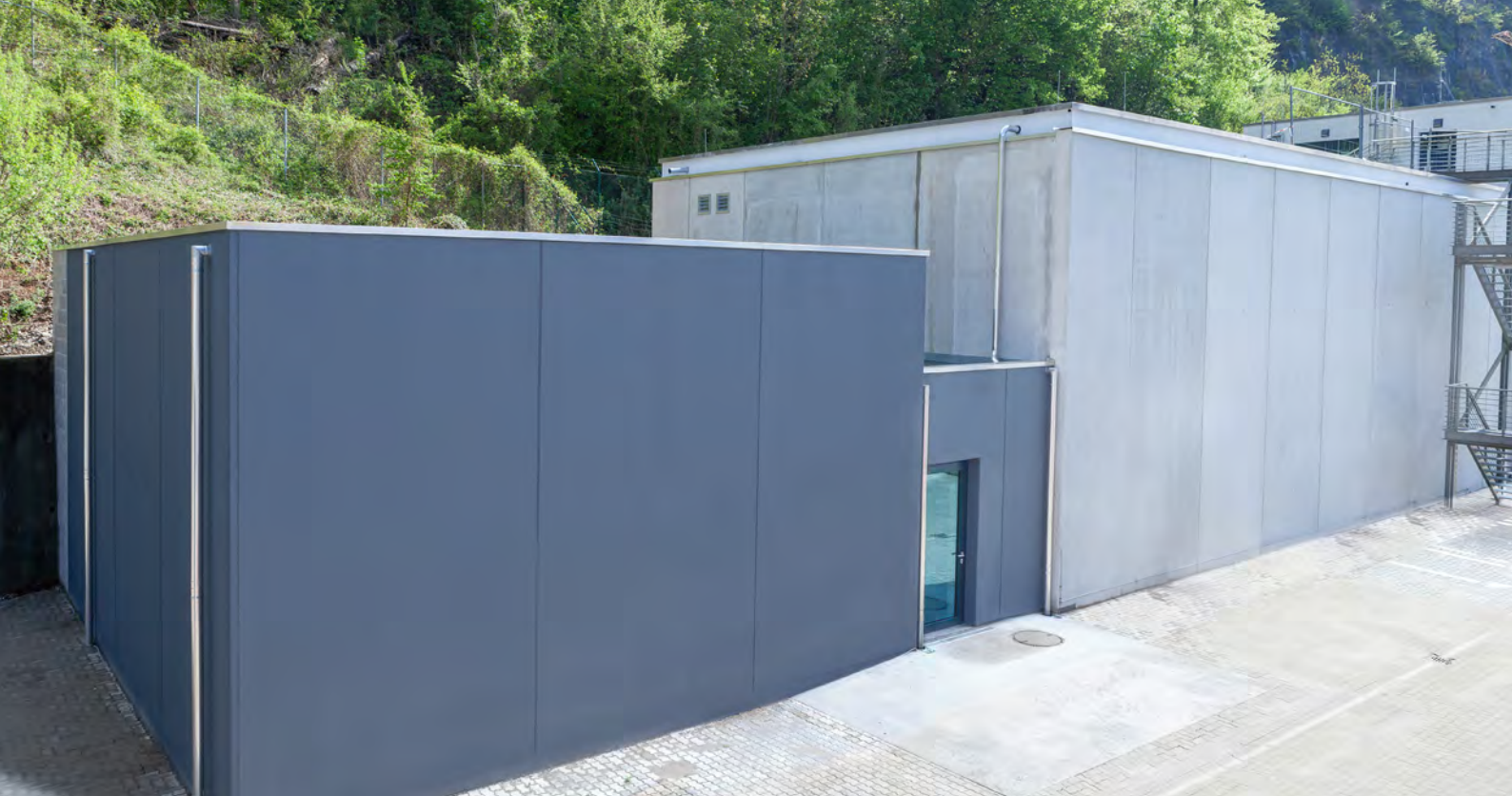
Außenansicht des neuen Linac-Labors LiLa, in dem sich der Linearbeschleuniger befindet.
